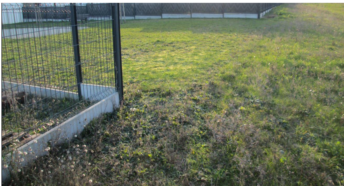
Figure 6 : Vue de l'exutoire prévu des eaux de ruissellement du bassin intercepté au niveau de la placette de la rue de Bellevue
