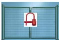
Le portail d'entrée d'une largeur de 7 mètres minimum doit posséder un système d'ouverture extérieur agréé par le SDIS (Dispositif de verrouillage avec triangle male de 11 mm)
