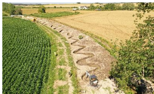
Figure 3 : Restauration de l'Yèvre à Baugy, SIVY 2020
