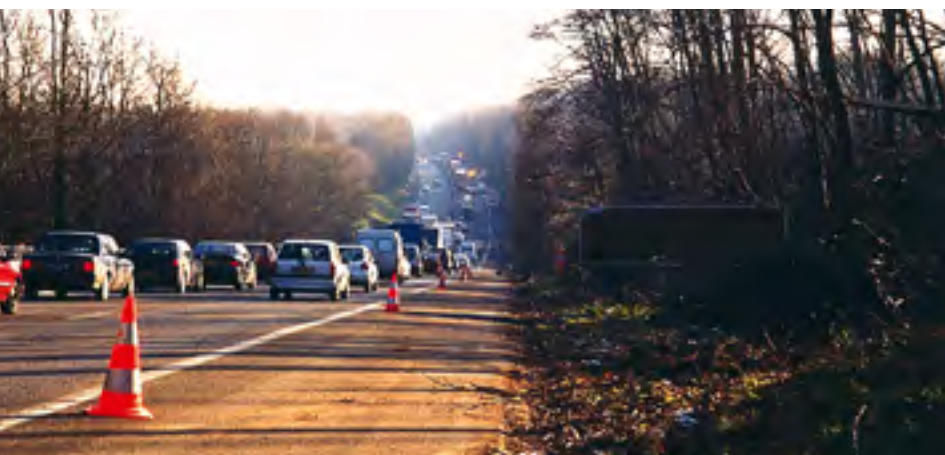
Exemple de balisage sur B.a.u. pour la protection d'un chantier de taille mécanique.
