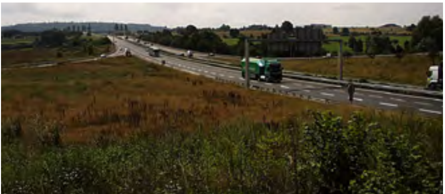
Les zones lointaines font l'objet d'un fauchage par an ou tous les 2 ans, et d'un débroussaillage tous les 3 à 5 ans.
