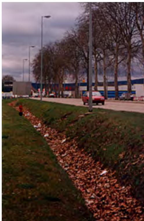
Ramassage par aspiration des feuilles dans le fossé.
