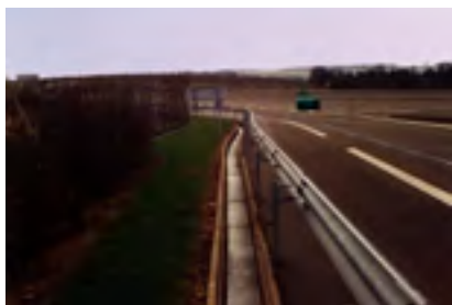
pied de glissière et caniveau propre.
