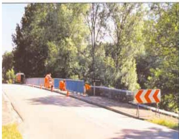
**Fonction :** Permet d'éviter la chute des piétons mais n'est pas un dispositif de retenue pour les véhicules. Les prescriptions techniques auxquelles doit répondre le garde-corps sont indiquées dans la norme XP P 98 405. On peut également consulter le fascicule « Garde-corps » du SETRA.
