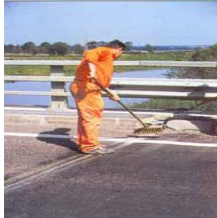
**Fonction** : Permet les mouvements relatifs (dilatation) entre le tablier et ses appuis ou deux éléments de structure, assure la continuité de la surface de roulement.
