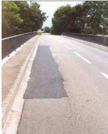
La chaussée d'un pont à tablier est constituée d'un revêtement en béton bitumineux mince, posé sur la chape d'étanchéité. Celle-ci garantit le bon état de l'ouvrage. Il est impératif d'éviter la moindre détérioration de la chape ; si une atteinte a été portée, il est obligatoire de faire procéder à la réparation par une entreprise spécialisée.
