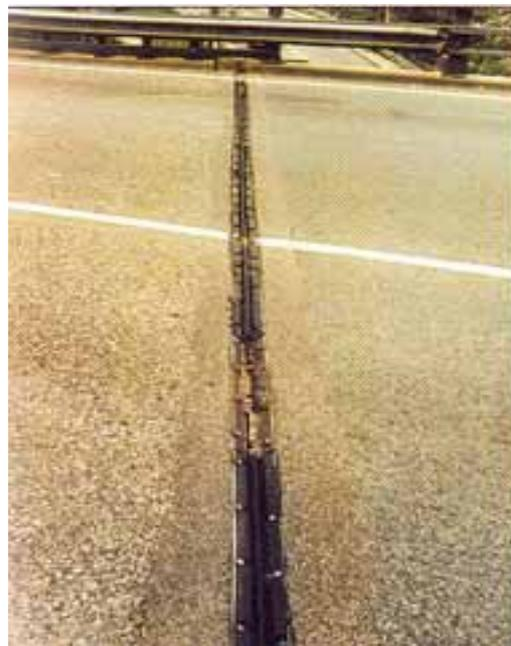
**Fonction** : permet les mouvements relatifs (dilatation) entre le tablier et ses appuis ou deux éléments de structure, assure la continuité de la surface de roulement.
