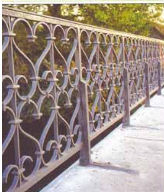
**Fonction** : Permet d'éviter la chute des piétons mais n'est pas un dispositif de retenue pour les véhicules. Les prescriptions techniques auxquelles doit répondre le garde-corps sont indiquées dans la norme XP P 98 405. Consulter le guide « Parapets, Garde-corps » du SETRA joint en annexe.
