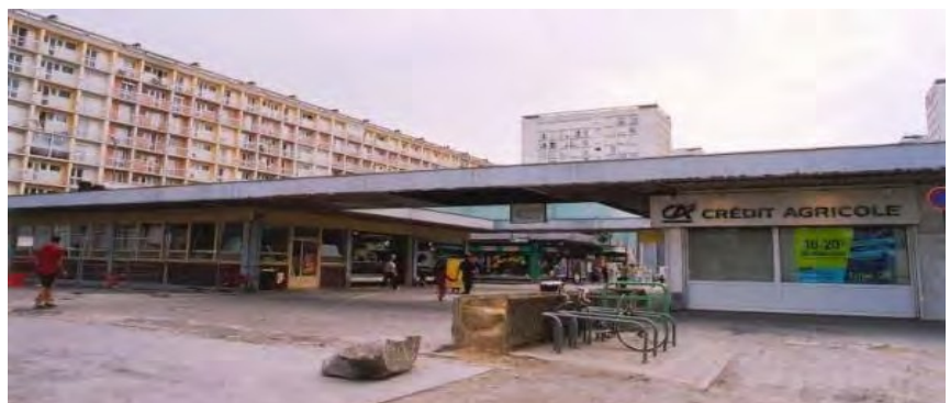
Vue de l'espace commercial avant travaux
