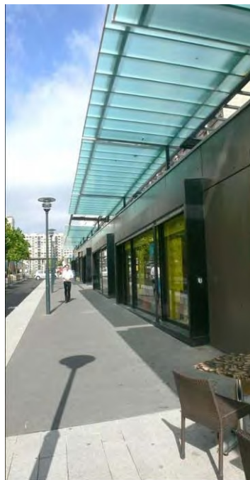
Vue de la rue commerçante après travaux
