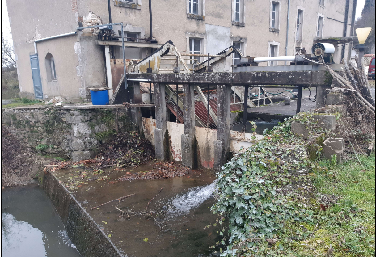
Figure 6 : PV4 - Vue vers la vanne de décharge 1.
