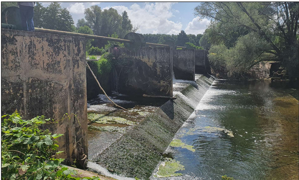
Figure 3 : PV1 - Vue vers le seuil et les trois vannes (source : MTBE, 2021).
