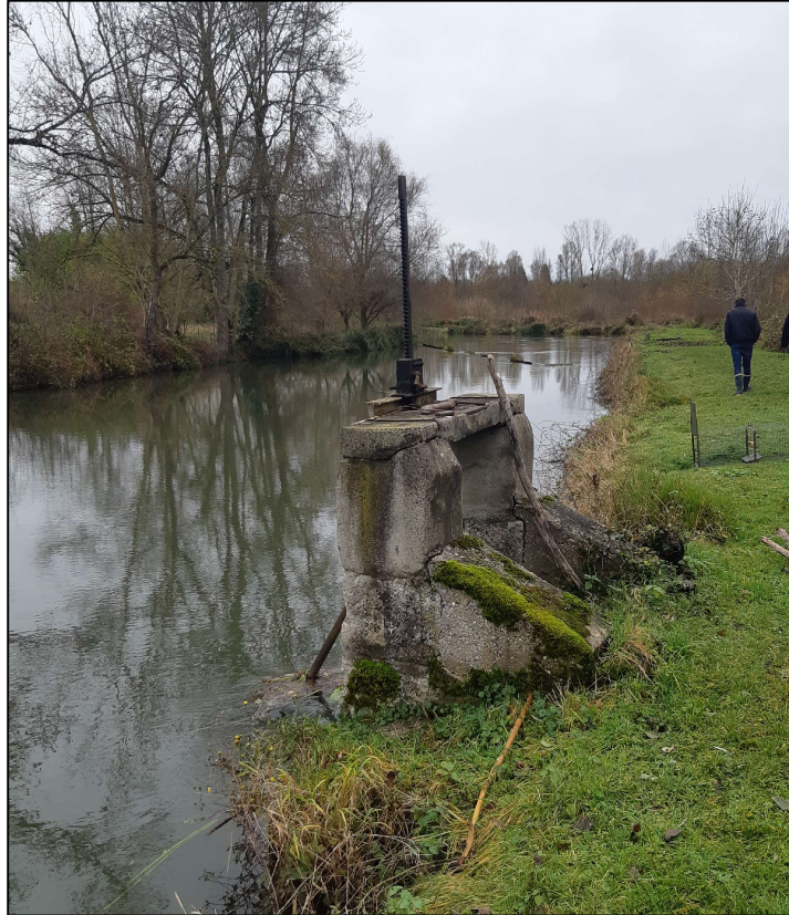
Figure 7 : PV5 - Vue vers la vanne de décharge 2.
