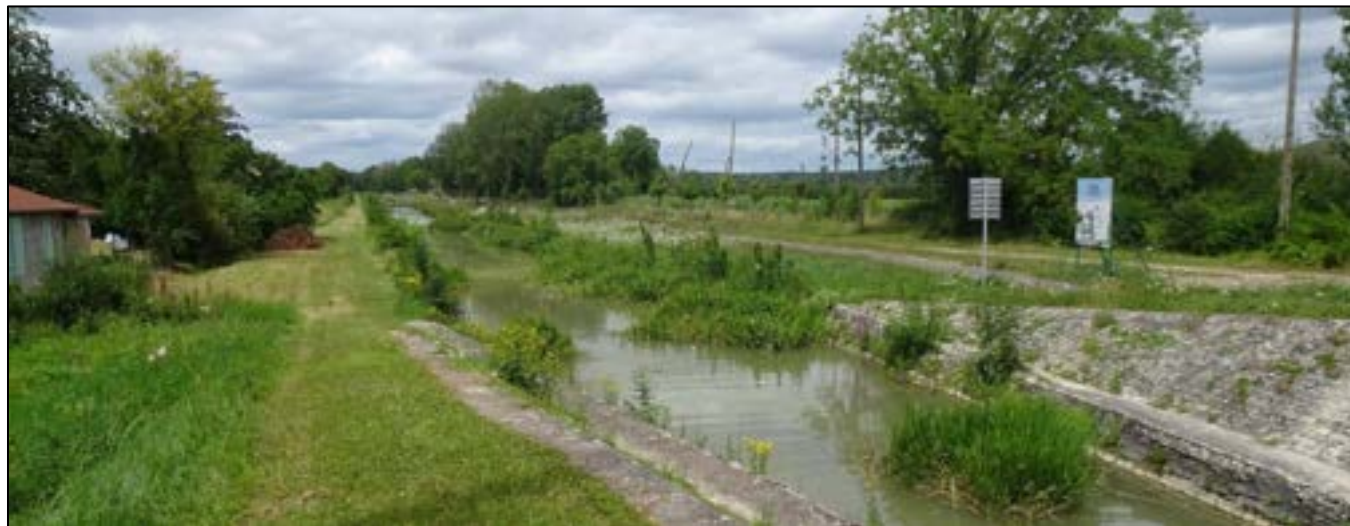
Figure 175 : Photographie de la traversée du canal de Berry, faiblement encaissé (Crédit photo : NCA Environnement)
