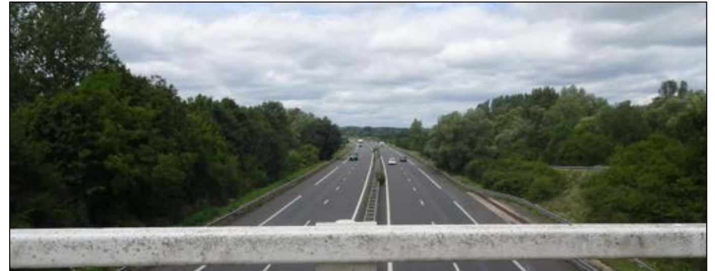
Figure 188 : Photographie de l'autoroute A71 (Crédit photo : NCA Environnement)
