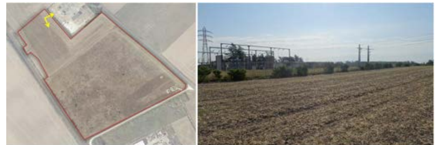
Figure 230 : Photographie du poste de transformation cadré par le champ cultivé (Crédit photo : NCA Environnement)
