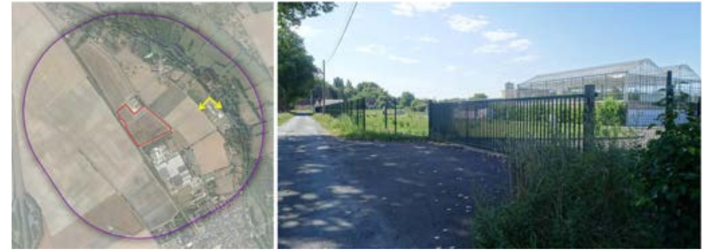
Figure 214 : Photographie du centre de traitement des eaux usées de Mehun-sur-Yèvre (Crédit photo : NCA Environnement)
