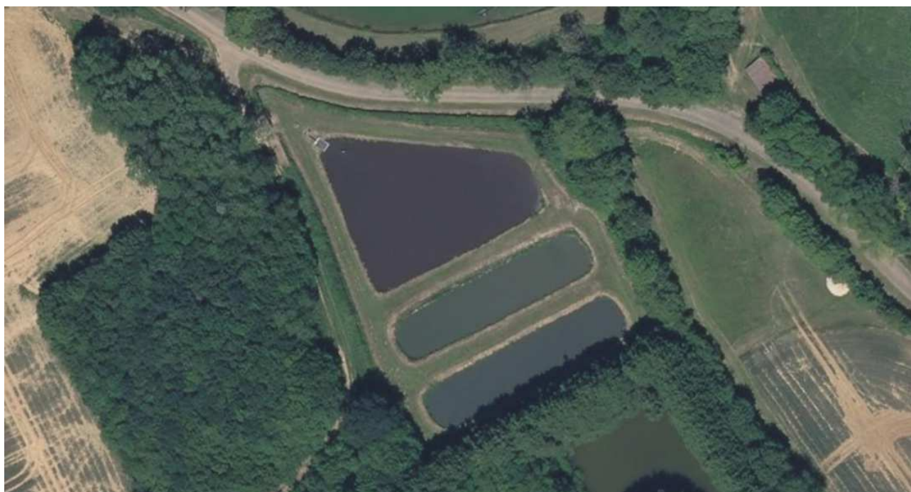
Figure 1 : Vue aérienne de la lagune (Source : Géoportail)
