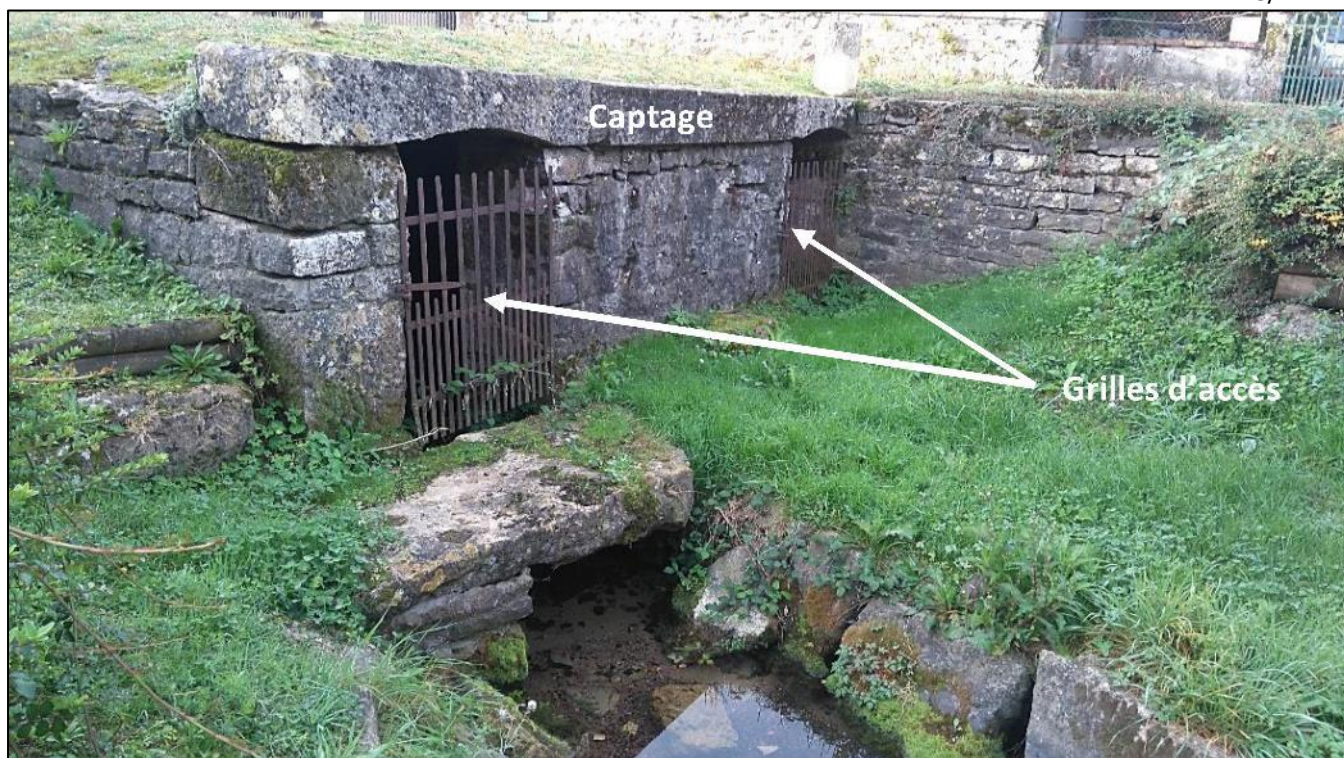
Figure 14 : Vue de la source maçonnée et ses grilles d'accès
