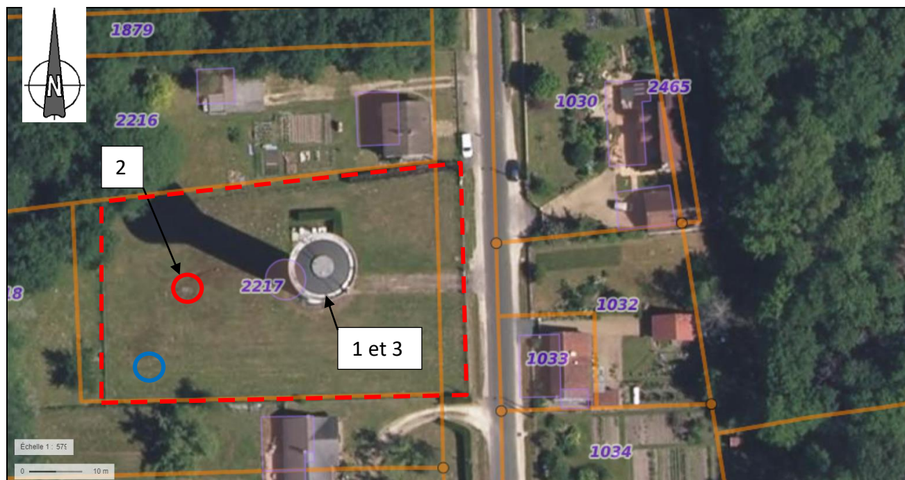
Figure 9 : Vue aérienne du site de production d'eau « Pot à l'Eau » à Neuvy sur Barangeon
