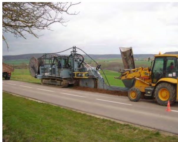
Réalisation d'une tranchée
