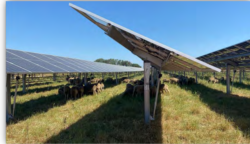
Exemple de structure de tables trackers
