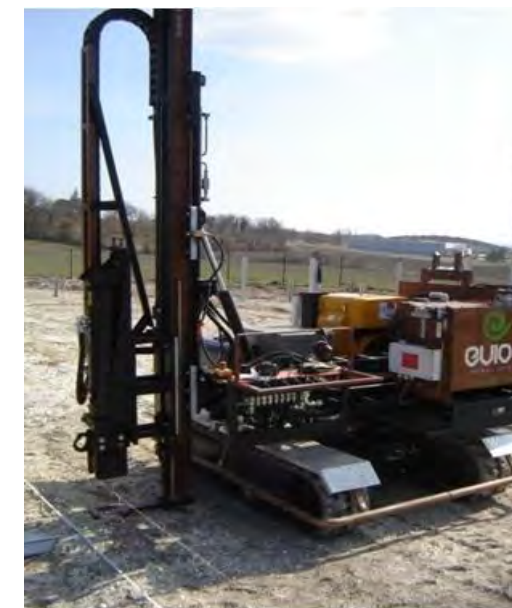
Engin de battage de pieux
