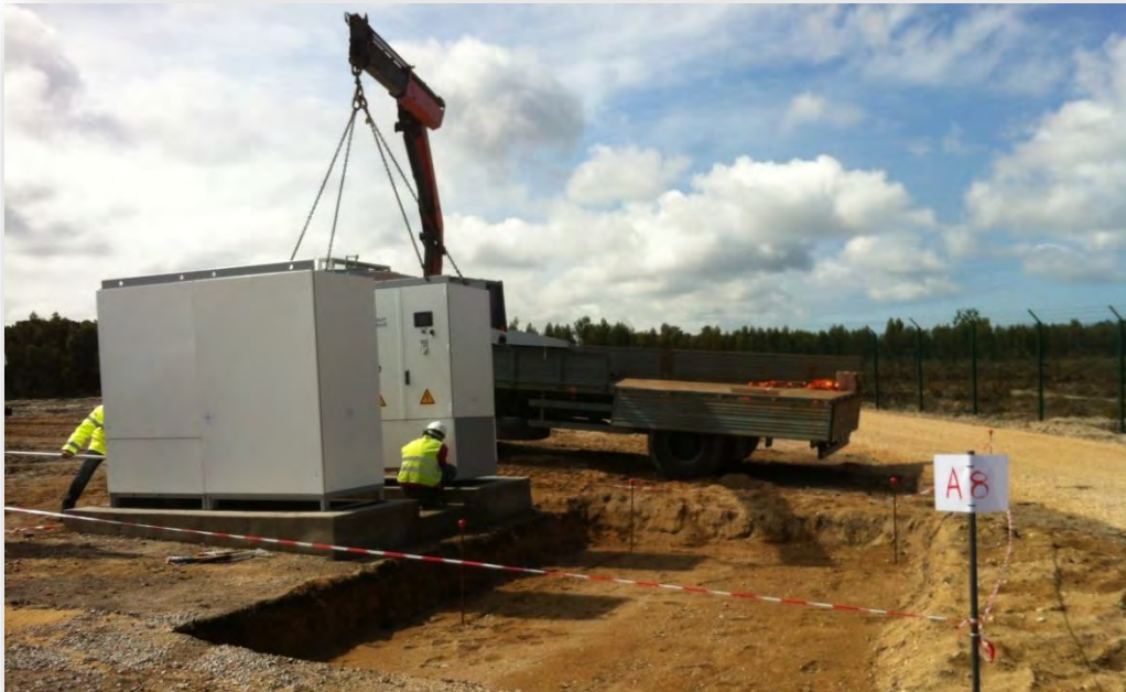
Exemple d'installation de poste de conversion outdoor
