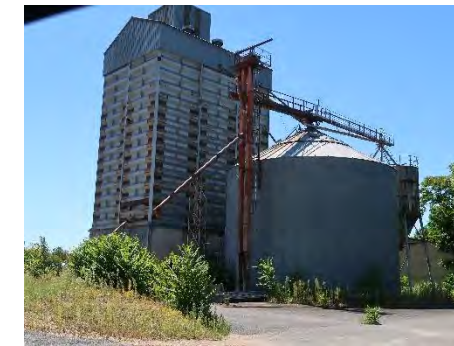
Silo à Chambon Source : ARTIFEX 2022
