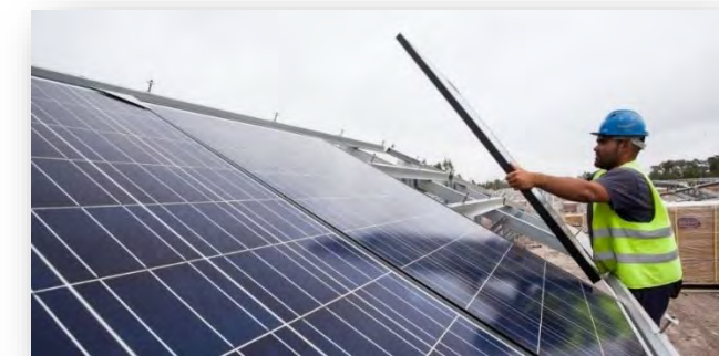
Pose de modules
