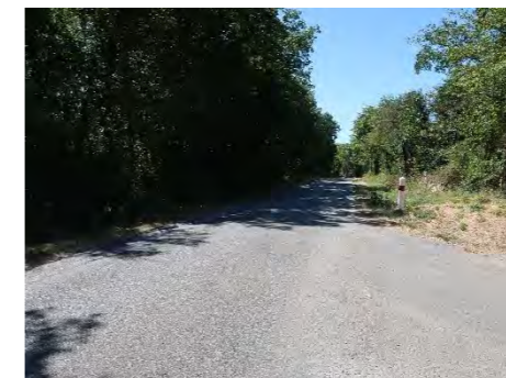
Route départementale D71 Source : ARTIFEX 2022
